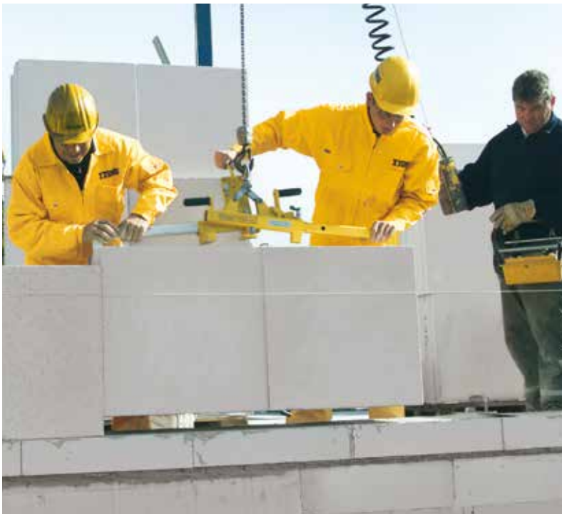
Minikran med dobbeltgriper plasserer 0,78 m 2 av gangen
