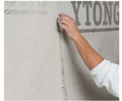
Baner av Ytong Armeringsnett monteres med 10 cm overlapp.
