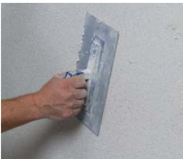
Overflaten glattes med plastbrett. Etter uttørring kan sluttpussen males med fasademaling.
