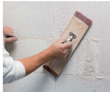
Reparasjonen avrettes med slipebrett, til overflaten er jevn. Reparasjons- mørtel skal være helt tørr, før det arbeides videre.
