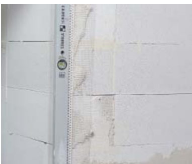
Utvendige hjørneprofiler monteres (se side 8). Lodd og vater kontrolleres.
