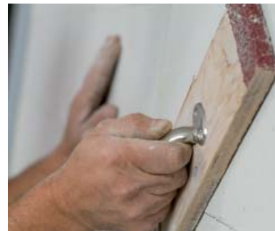
Når sparkelmassen er herdet, slipes med slipebrett.
