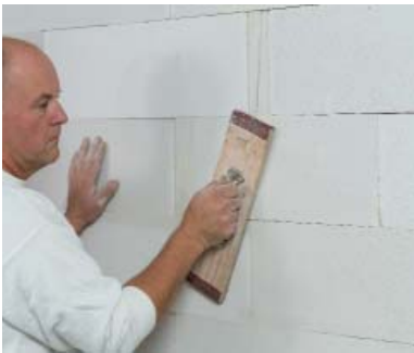
Limrester fjernes og mindre nivåut-spring utjevnes med slipebrett.
