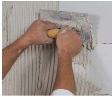
Ytong Grunnpuss trekkes på hele veggflaten med 10 mm tannsparkel.
