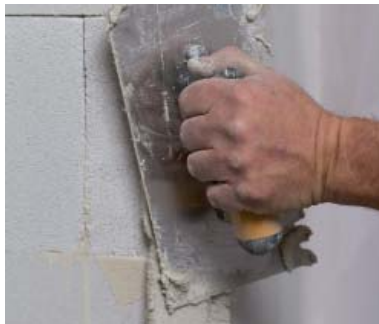
Deretter trekkes det ut over hjørnet fra tilstøtende veggflate, således at hjørnet står skarpt.
