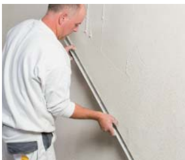
Veggflatens planhet undersøkes med rettholt.
