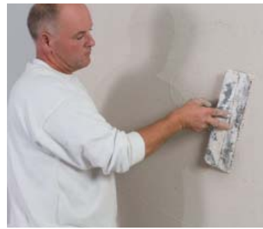
Grunnpussen glattes til helt jevn overflate.
