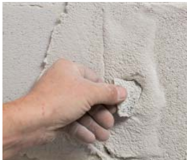
Sår og skader utbedres med Ytong Re-parasjonsmørtel. Ved større sår legges stykker av Ytong Porebetong i Reparasjonsmørtelen.
