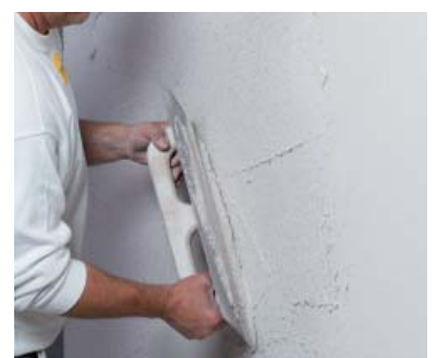
Ytong Sluttpuss trekkes på med stålbrett i et tynt lag.
