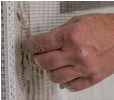
Hjørneprofilen monteres med Ytong Grunnpuss.
