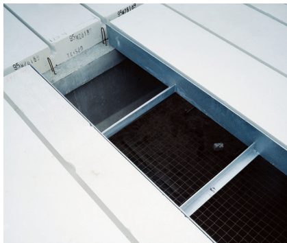
Figur 2: Stålramme H-form
