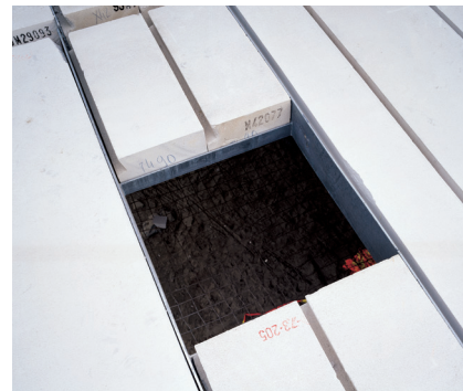
Figur 3: Dekke i stålramme
