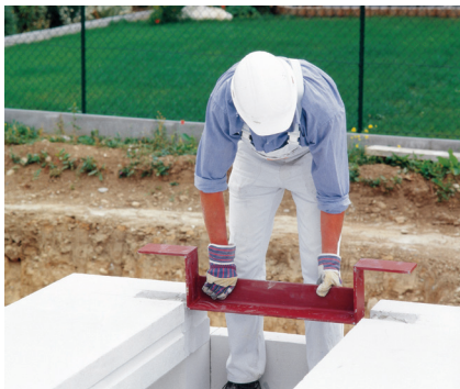
Figur 1: Utsveksling mellom dekker
