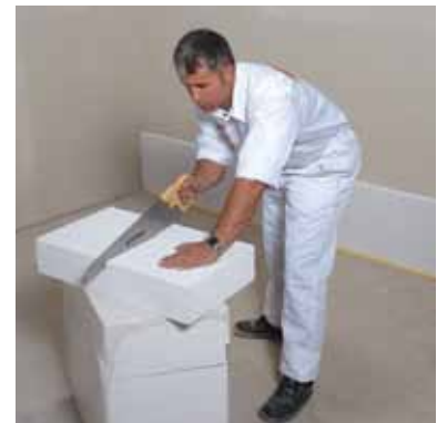
Multipor tilpasses nemt og præcist med en fintandet sav og slibenet.
