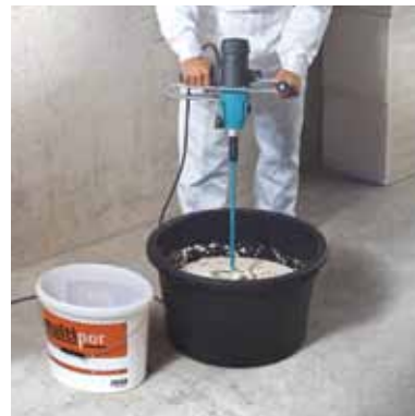
Multipor Letmørtel oprøres med vand. 20 kg pulver blandet med 8 l vand giver ca. 30 l mørtel.
