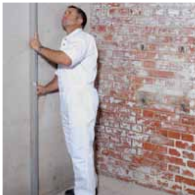
Underlaget rettes af til +/- 3 cm målt over en retholt på 2 meter. Større huller og lunger spartles eller pudses.
